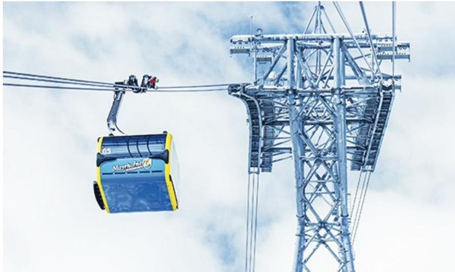
Pylône avec virage de 6°. L'inclinaison latérale éventuelle n'est pas visible, alors que la ligne est comparable aux tronçons du Funiflaine (longueur 3km, dénivelé 1100m, 3 pylônes). La longueur du sabot est de 50m.
